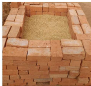
Figure 3: Incinérateur pour la balle de riz
