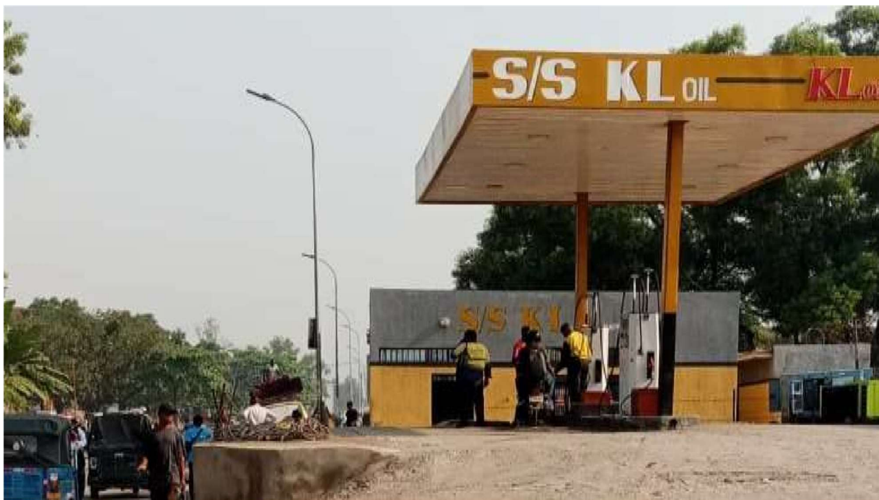
Figure 13. Image d'une station-service construite à moins d'un mètre de la chaussée sur l'avenue université.
