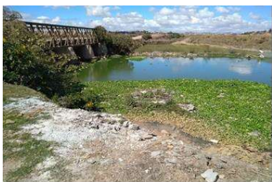
Photo 1a : Déversement direct de boue de vidange dans le canal C3 Andriantany à Ambohitrmanjaka
