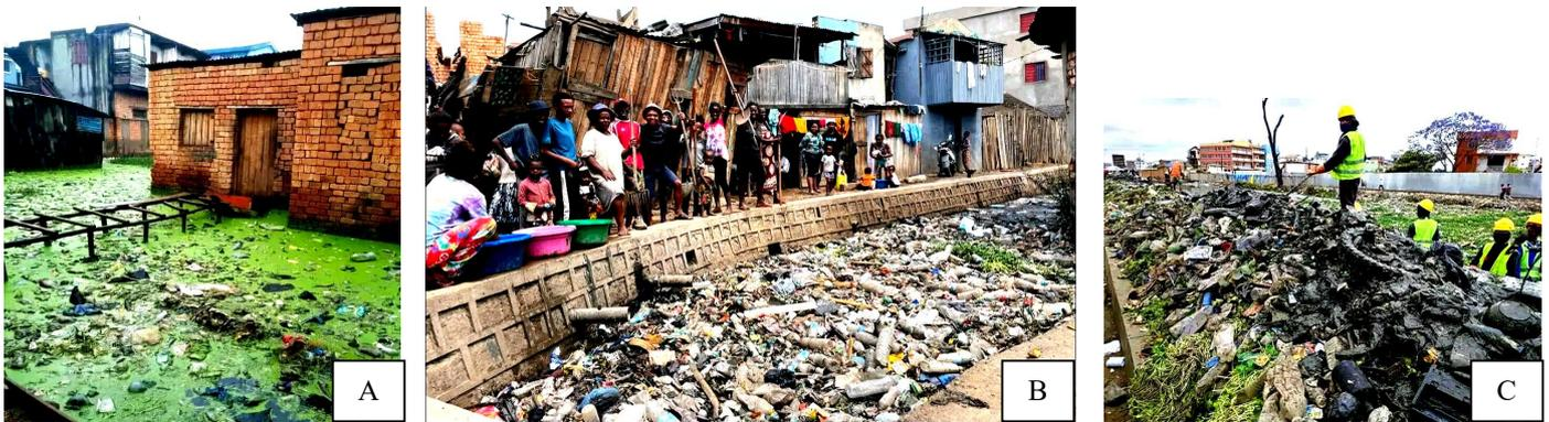
Fig. 16. Facteurs diminuant les capacités de fonctionnements des collecteurs d'eaux pluviales, A: construction illicite dans le bassin de rétention d'Anosibe, B: accumulation de déchets solides dans le drain secondaire côté Namontana, C: accumulation de déchets solides dans le canal C3 côté 67 ha.
