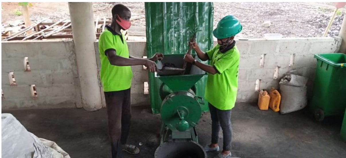
Photo 7 : broyage des déchets carbonisé
