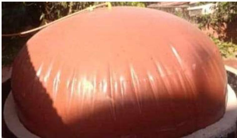
Fig. 2 : Vue du biodigester à bache sur nappe phréatique basse de 40 m<sup>3</sup>
