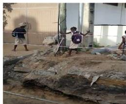
Photo 9 : fouille mal balisée sur la rue 12437 à côté de EPP Jacquot
