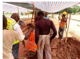
Photo 18 : Non port d'EPI par un ouvrier
