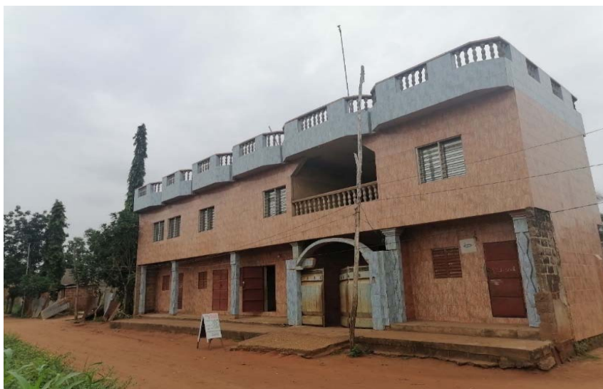
Photo 4 : Habitation de haut standing dans le village de Glo-Yovozinsa
