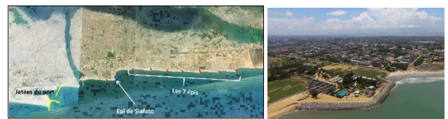
Photo 3 : Image Google Earth 2017 montrant les épis et jetées du port de Cotonou
