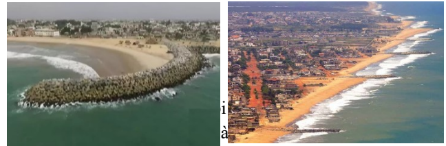
Planche 1 : Epis aménagés sur la côte Est de Cotonou, images récupérées sur internet
